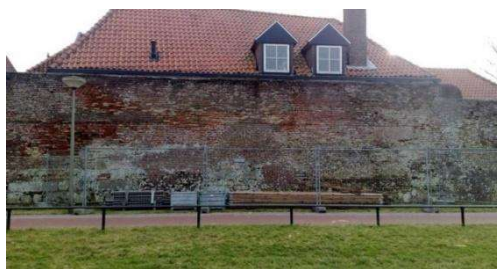
De gereconstrueerde stadsmuur
