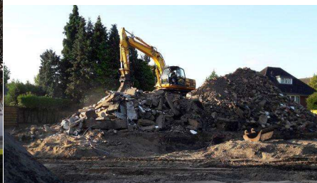
Sloop Nieuwe Kerk aan de Stationslaan
